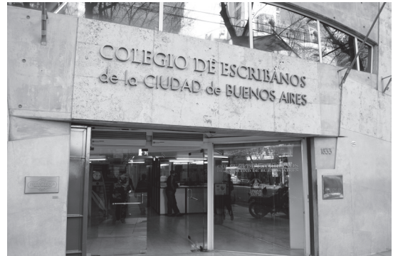
Edificio de Las Heras 1833, proyecto del arquitecto Clorindo Testa
