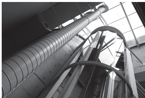
Detalles del ascensor en el edificio de Las Heras
