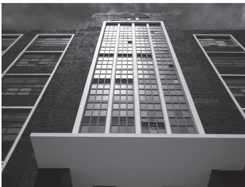
Frente del edificio de la calle Chorroarín 731
