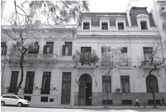
Fachadas de los edificios de Callao 1540 y 1542
